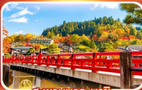
สะพานนากะบาชิ
